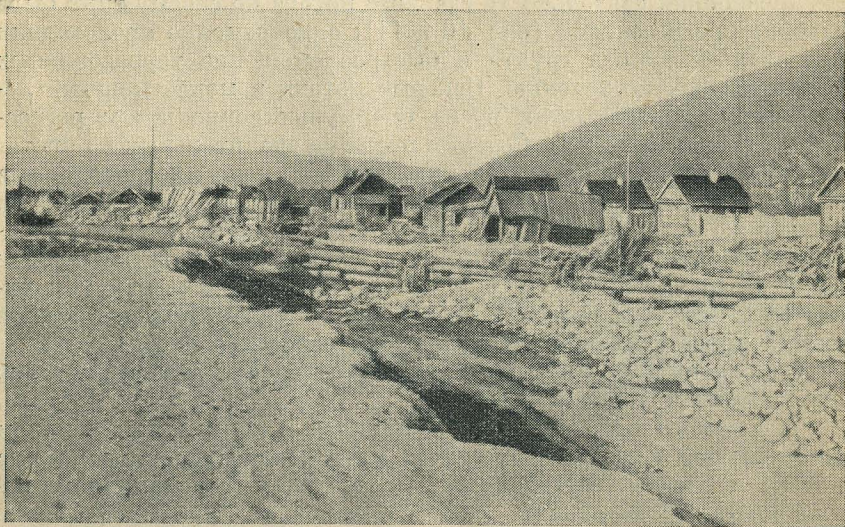
Рис. 9. Поселковая ряжевая дамба. На переднем плане новое селевое русло.
