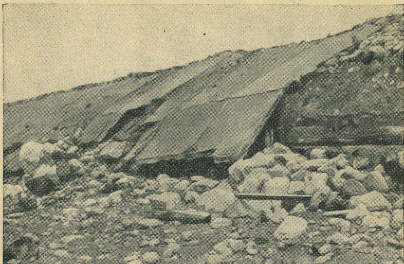
Рис. 20. Разрушение правобережной дамбы с железобетонным покрытием. (Фото Г. Иванова. 28. VI 1960 г.)
