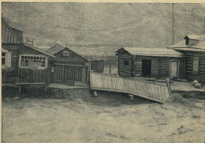
Рис. 16. 12 час. 13 мин. 20.VI 1960 г. Поток подмывает дома. Веранда левого дома подмыта, рухнул забор.
