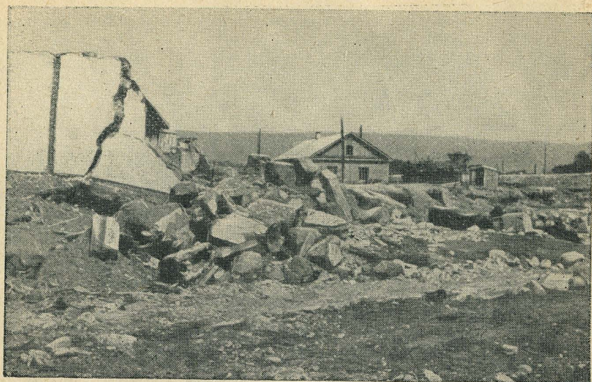
Рис. 19. Характер разрушения шлаколитых домов.
