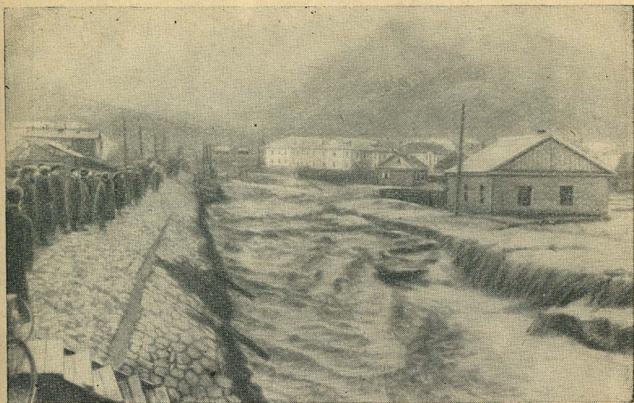
Рис. 10. Глубинно-регрессивная эрозия главного селевого потока, следующего вдоль дамбы, и начало регрессивной эрозии бокового (справа) потока.
