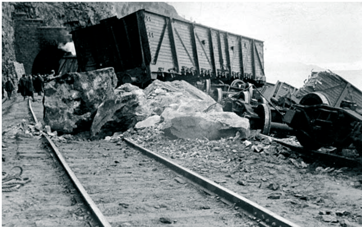
Рис. 1.2.2.2.1. Последствия обвала в мае 1941 г. у восточного портала тоннеля № 5 (87-ой км КБЖД). Фото с сайта www.transsib.ru
