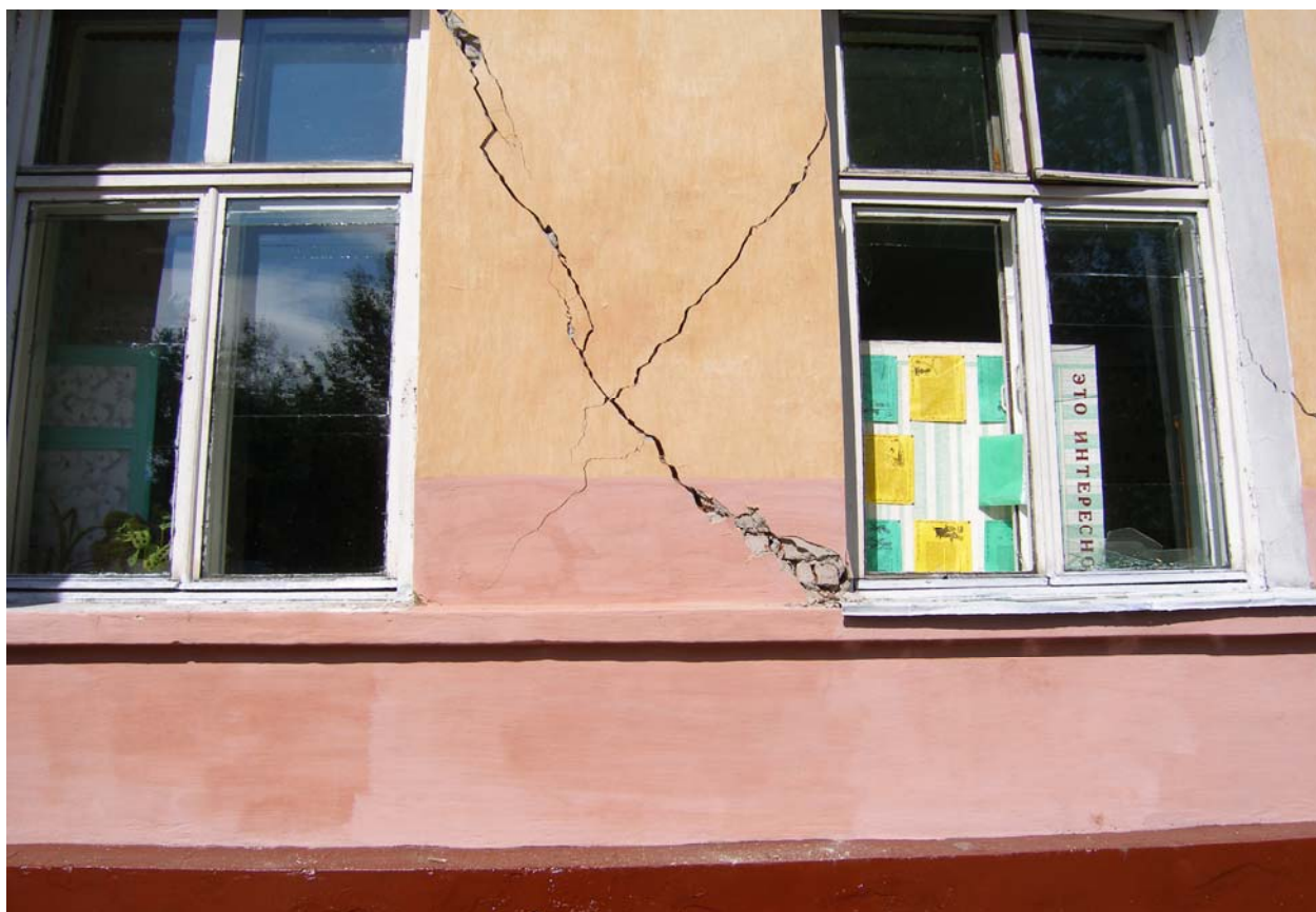
Рис. 1.2.2.1.5. Трещины в стене здания школы в поселке Култук после землетрясения 27 августа 2008 года
