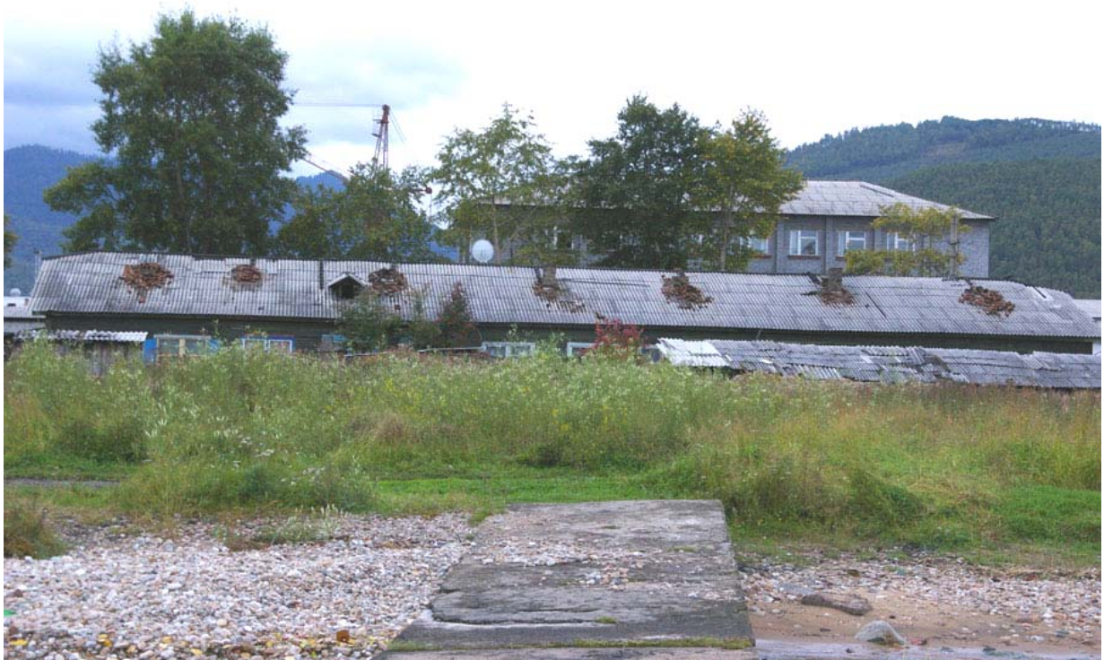
Рис. 1.2.2.1.3. Разрушение печных труб в поселке Култук во время землетрясения 27 августа 2008 года. Подобные разрушения имели массовый характер в Култуке, Утулике и Слюдянке.
