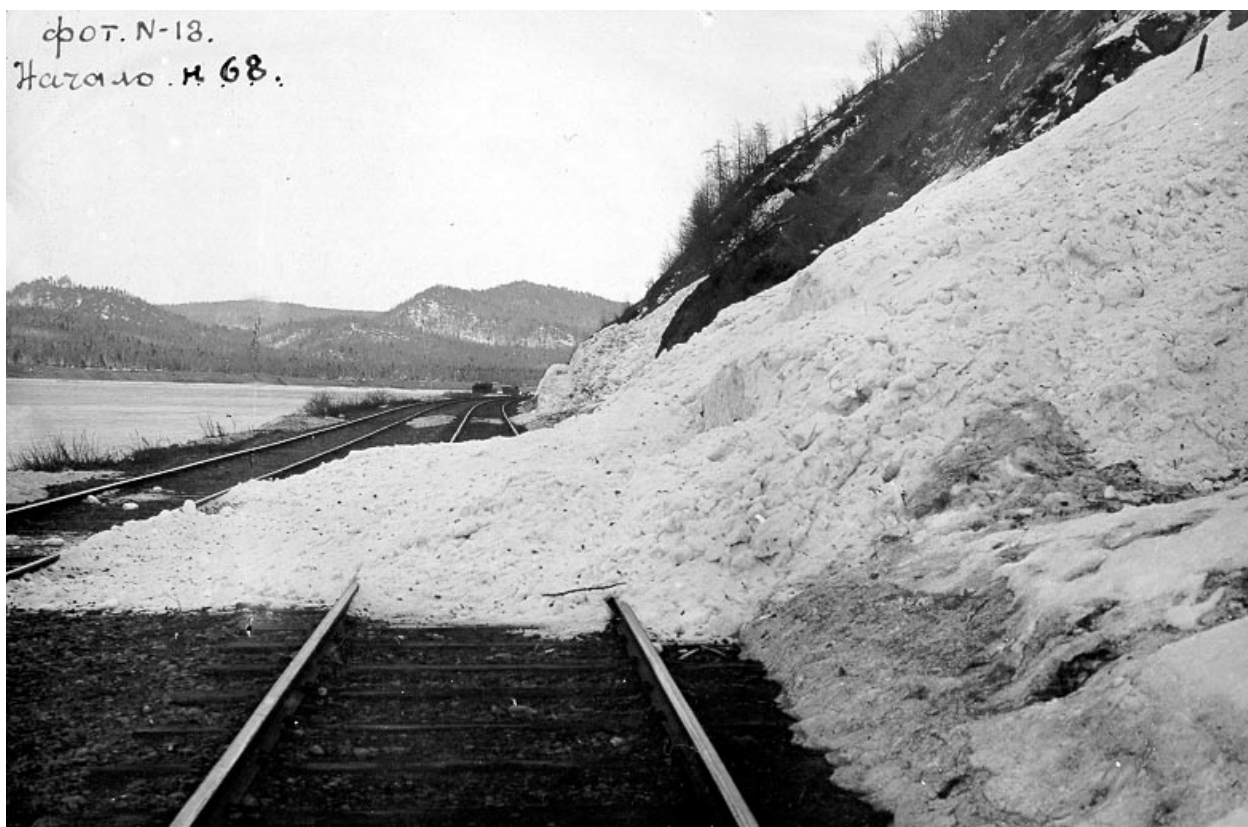
Рис. 1.2.2.2.2. Завал железнодорожных путей в результате схода лавины в 1925 году в районе 68-го км КБЖД. Фото с сайта www.transsib.ru
