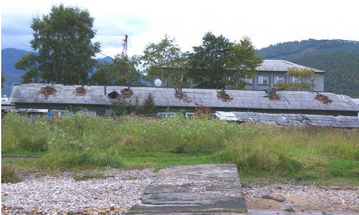
Рис. 1.2.2.1.3. Разрушение печных труб в поселке Култук во время землетрясения 2 августа 2008 года. Подобные разрушения имели массовый характер в Култуке, Утулике и Слюдянке.
