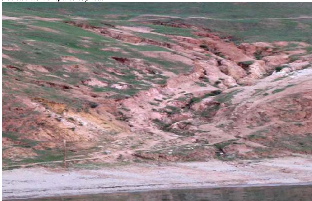
Рис. 1.2.2.2.4. Разрушение овражной эрозией проселочной дороги в районе поселка Хужир на острове Ольхон. Фото с НИС «Исток».
