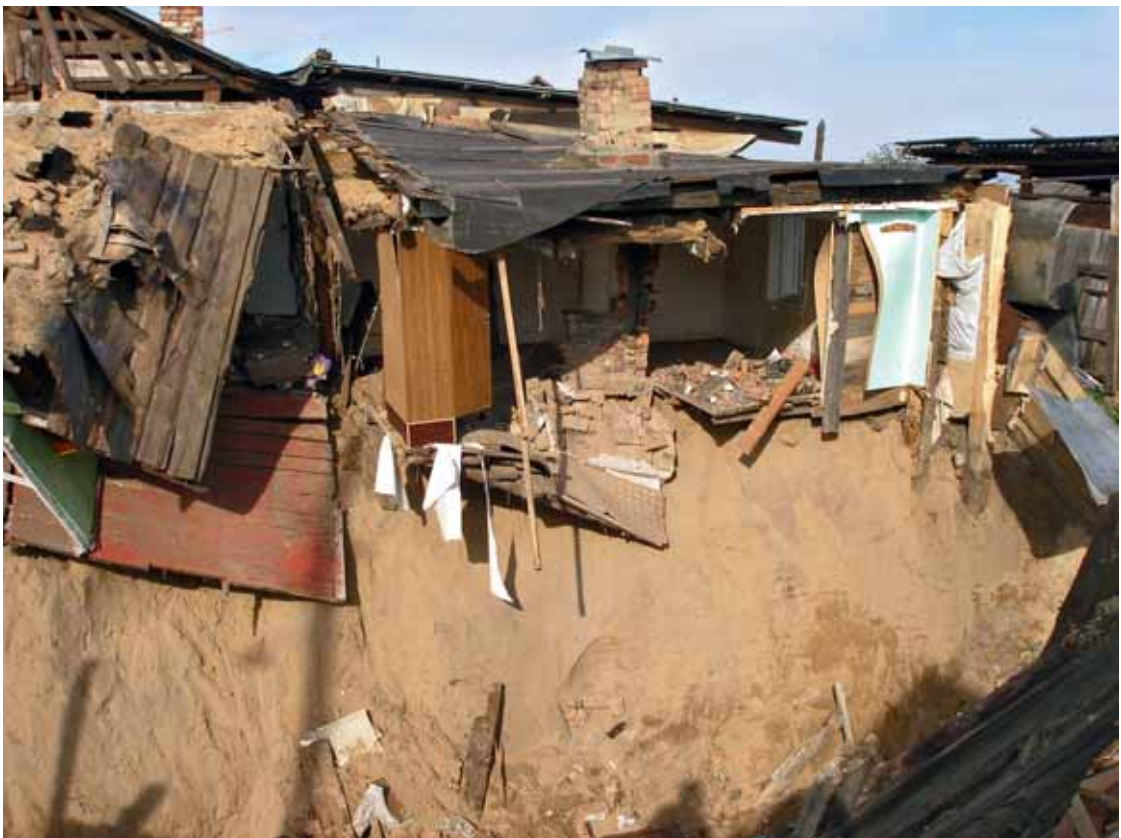
Рис. 1.2.2.2.1. Обрушение жилого дома и надворных построек в городе Улан-Удэ на ул. Бийская, д. 39 в результате катастрофической активизации овражной эрозии
