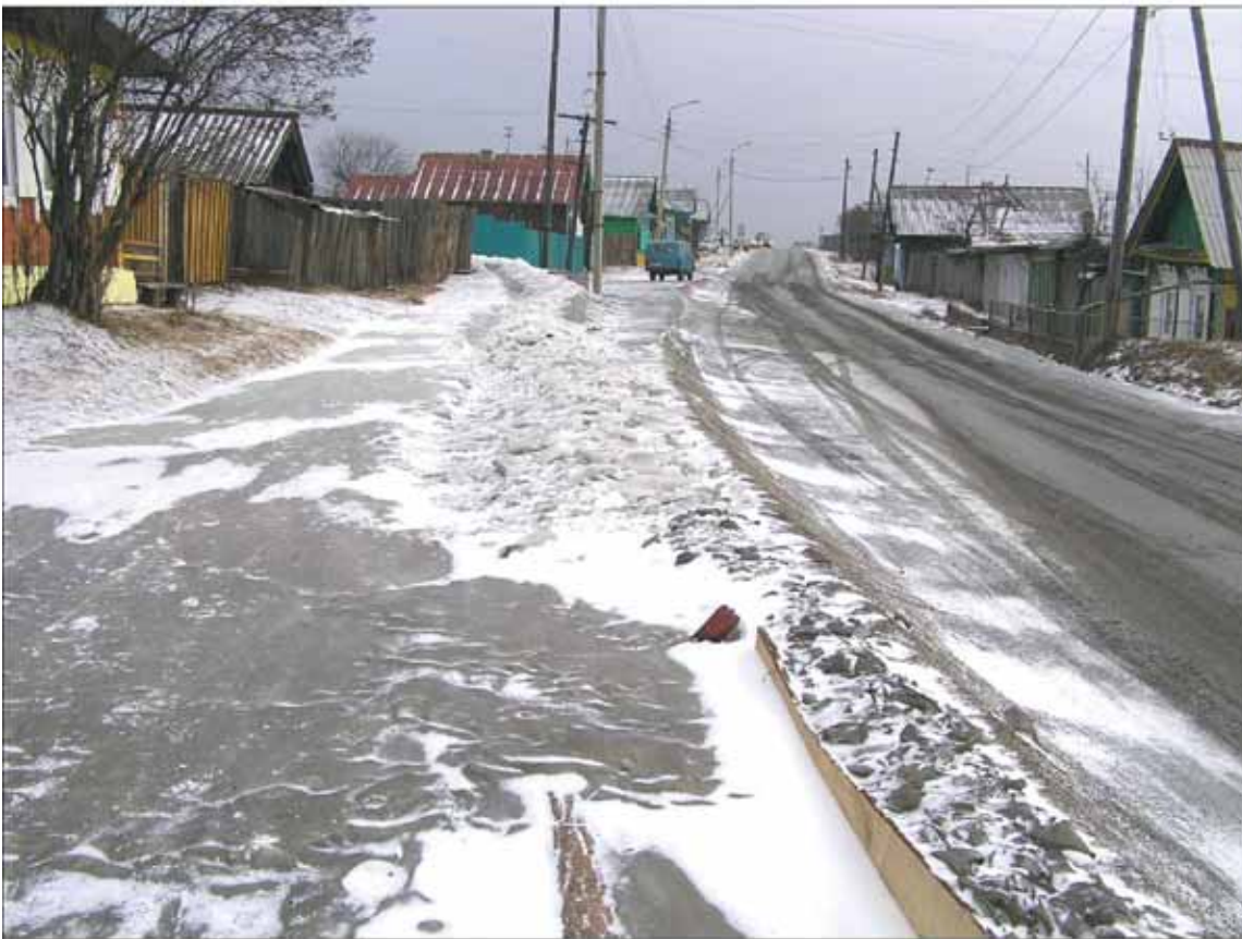
Рис. 1.2.2.2.3. Воздействия наледи на ул. Панфилова в поселке Култук Слюдянского района Иркутской области на автодорогу А-164 (Култук-Монды)
