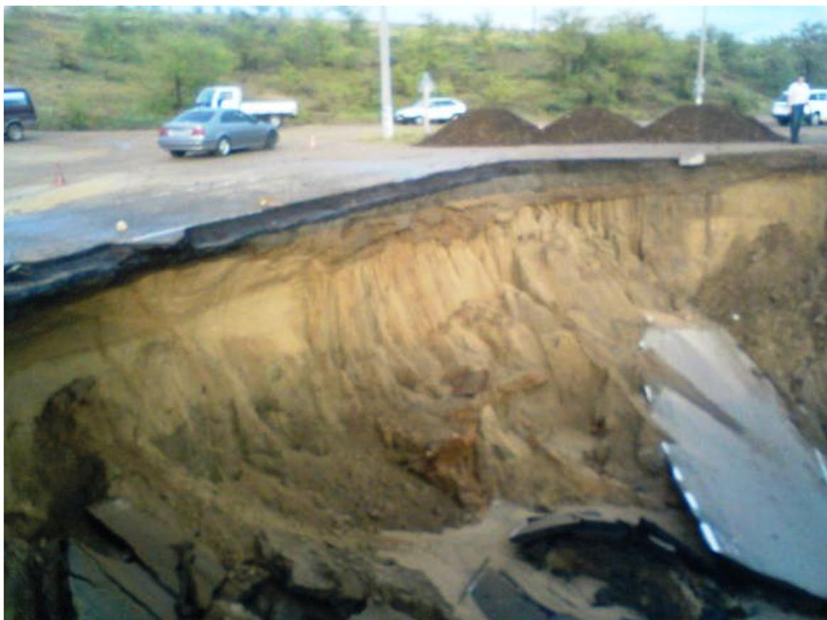
**Рис. 1.2.2.2.1. Проявление эрозионных процессов на автодороге А-165 Улан-Удэ – Кяхта**
