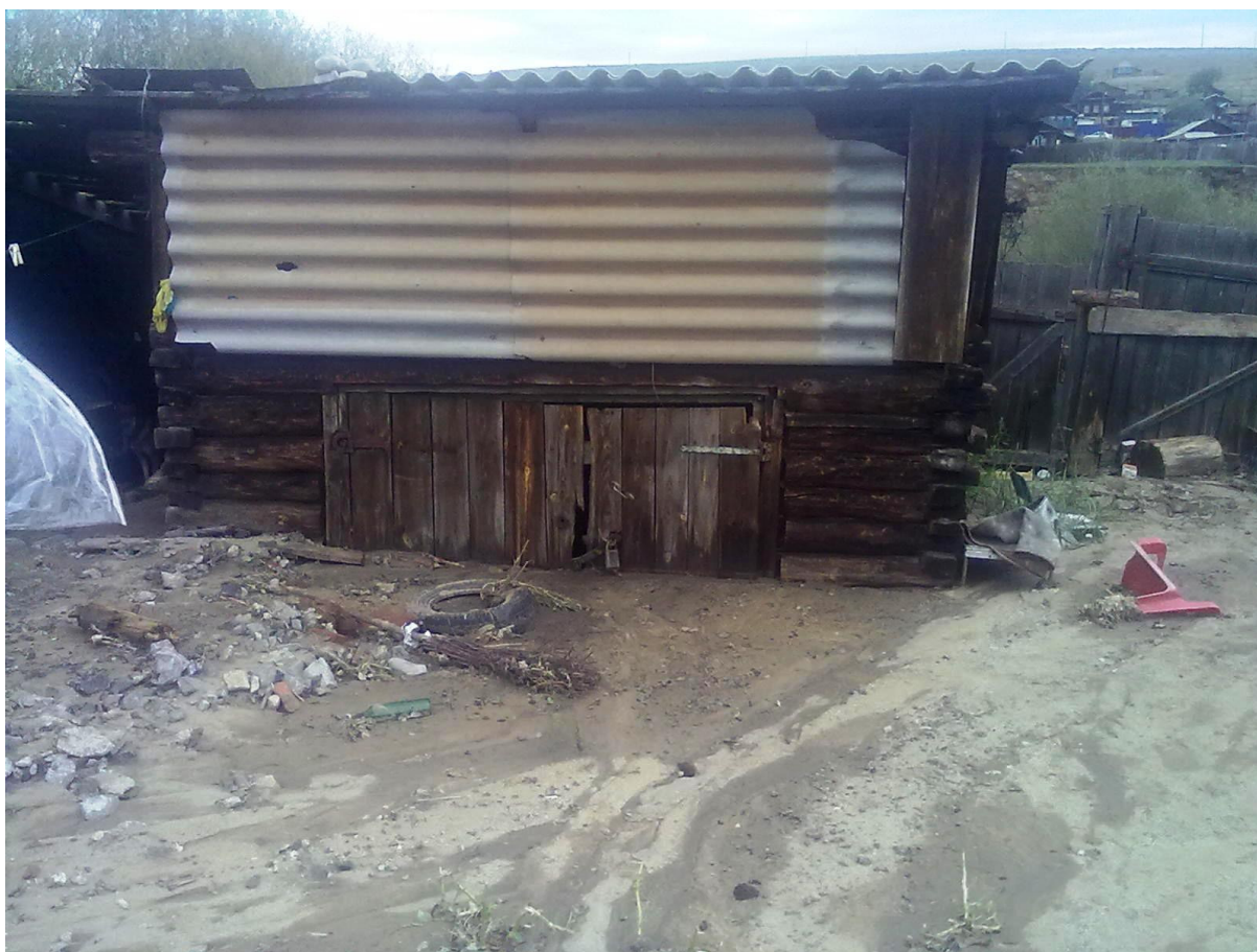
Рис. 1.2.2.2.2. Проявления эрозионных процессов в частном секторе г. Кяхта
