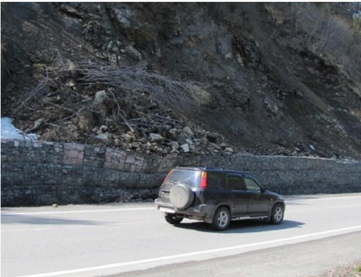
**Рис. 1.2.2.2.6. Деформация подпорной стенки на автодороге М-55**
